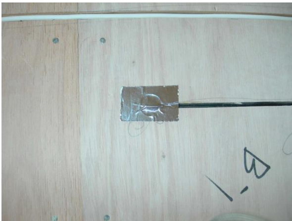
温度センサーの溝配線施工例です。 ケーブルの太さに合わせた溝幅に加工してください。
